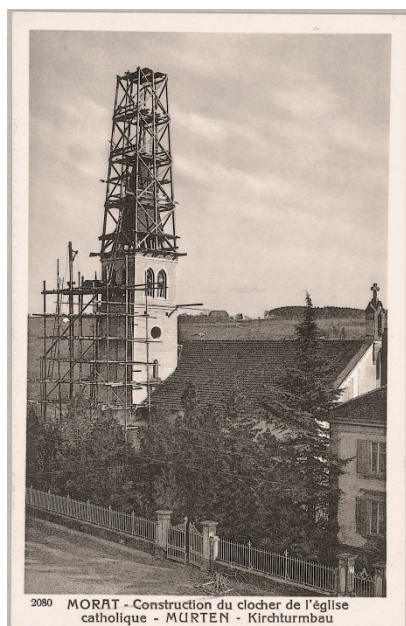
Abb. 9: Glockenturm im Bau
